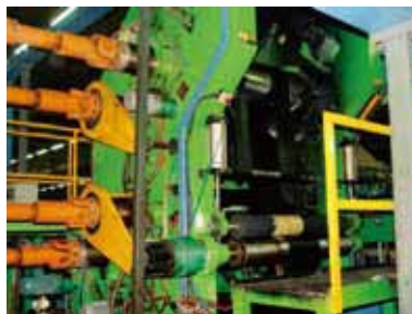
壓延系統電氣改造工程
